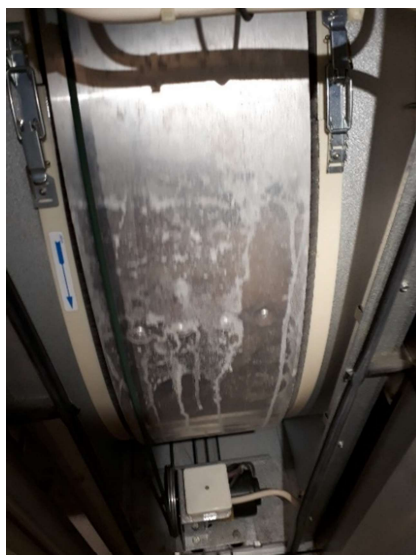
Vesilammikko raitisilmasuodattimien kammiossa. Vesijälkiä LTO-kiekossa.
