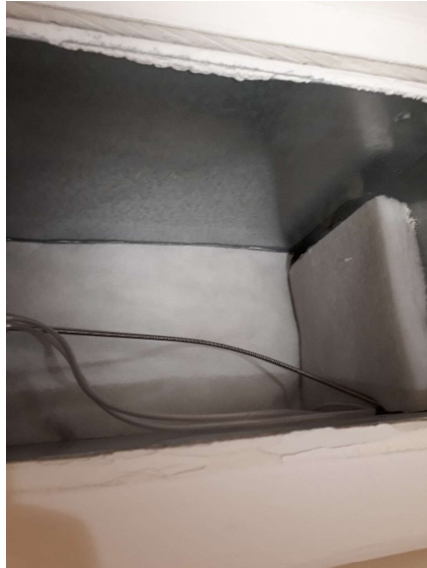
Äänieristeenä on muovieristettä.
