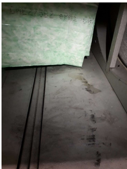
Vesilammikko raitisilmasuodattimien kammiossa. Vesijälkiä LTO-kiekossa.
