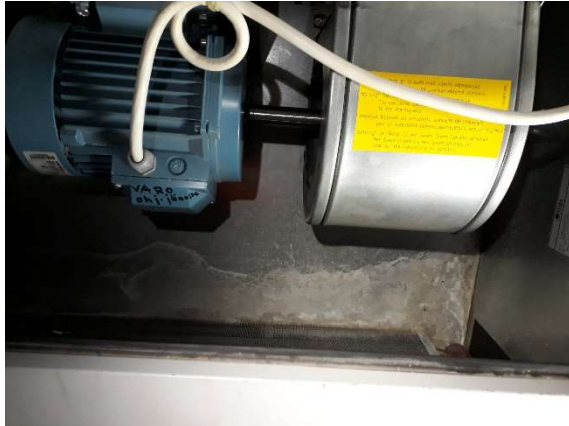
TF-1.1 tulopuhallinkammiossa on vesijälki. Kuva suodatinkammioista, vesijälkeä ja vettä.
