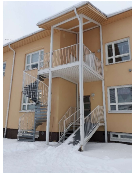
Takapihalla varaueloskäynnin runko on teräsrakenteinen ja lattia kyllästettyä puuta.
