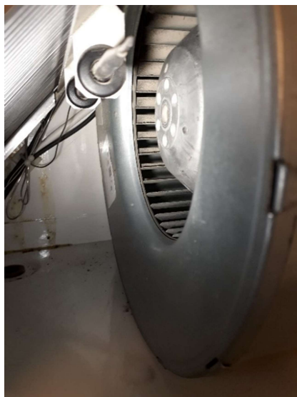
Puhallinsiivekkeet ovat pölyiset.
