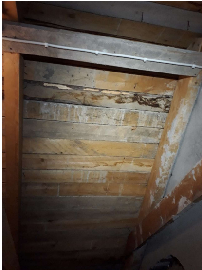
Rakennuksen keski- ja pohjoisosassa havaittiin useita vesijälkiä ruoteissa. Tuoretta vesikattovuotoa ei havaittu (pakkaskelit).
