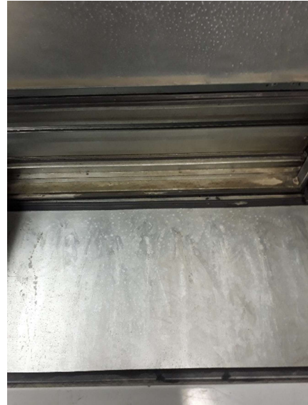
TF-1.1 tulopuhallinkammiossa on vesijälki. Kuva suodatinkammioista, vesijälkeä ja vettä.
