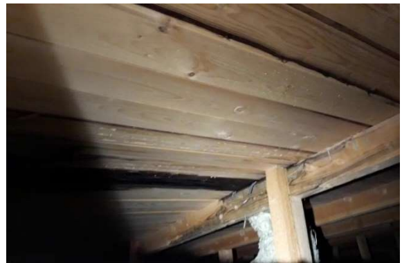
Vesivuotojälki viemärin tuuletusputken juuressa, josta vesi on valunut 4 metrin matkan ruoteita pitkin.
