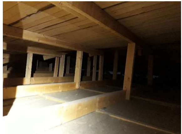
Yläpohja on puurunkoinen.
