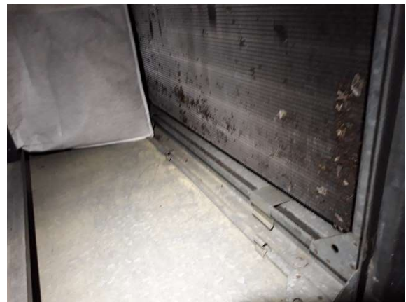
Tulosuodattimen kaulukseen jää noin 5 mm
