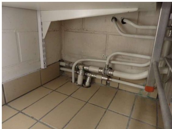
Vesijohtoja on uusittu.
