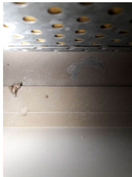
Pääaulassa tuloilmaelimessä on mineraalivillaa. Tuloilmaelin on erittäin pölyinen.
