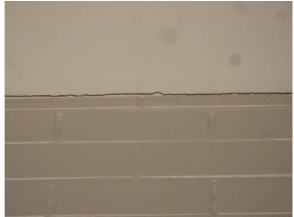
Liikkumista liikuntasalin katon rakenteessa.
