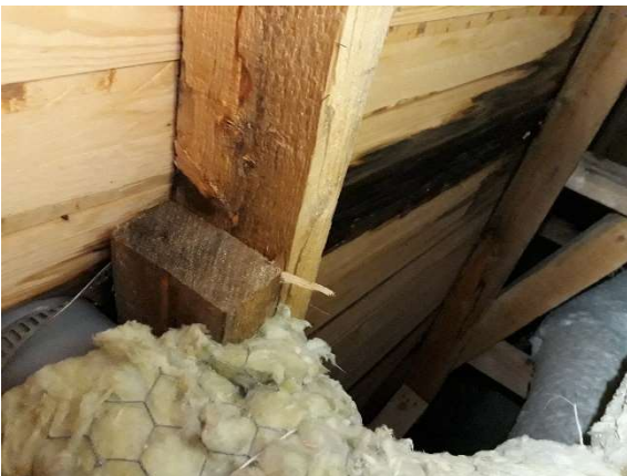
Vesivuotojälki viemärin tuuletusputken juuressa, josta vesi on valunut 4 metrin matkan ruoteita pitkin.
