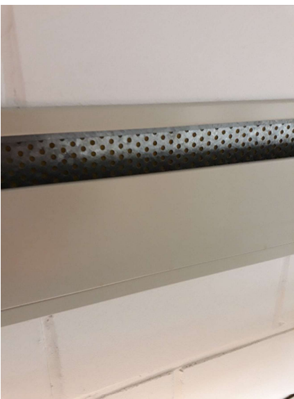
Pääaulassa tuloilmaelimessä on mineraalivillaa. Tuloilmaelin on erittäin pölyinen.
