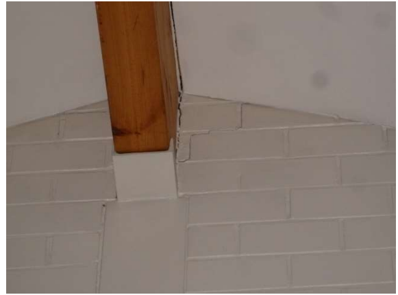
Liikkumista liikuntasalin katon rakenteessa.
