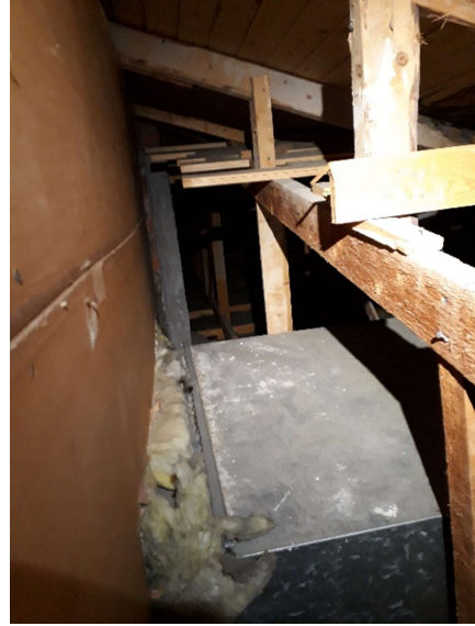
IV-konehuoneen raitisilmakanavan läpivienti.
