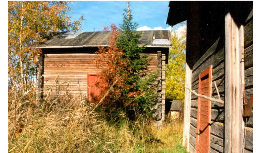
Humalaharjun aitat, joista vasemman puoleinen on entinen Ukonmäen myllyrakennus.
